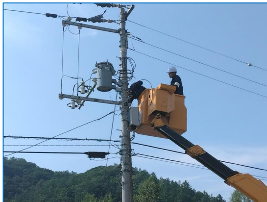
▲ 高所作業車のバケットに乗り、より近くで作業の様子を見て頂きました
